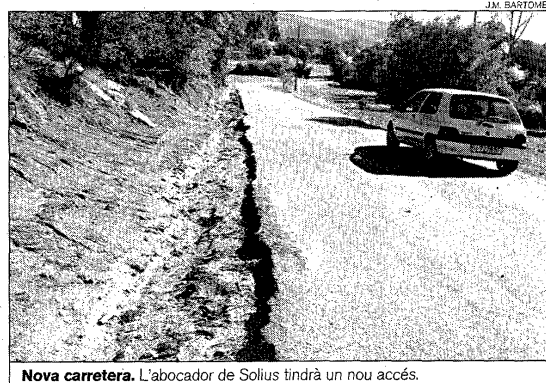
Nova carretera. L'abocador de Solius tindrà un nou accés.
