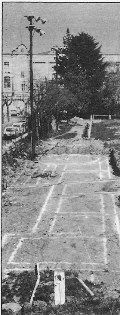
Escola del Veïnat. Inici de les obres. Abril 1990
